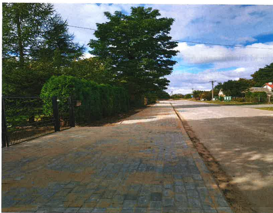
2. Budowa chodnika w Radoszynie,
