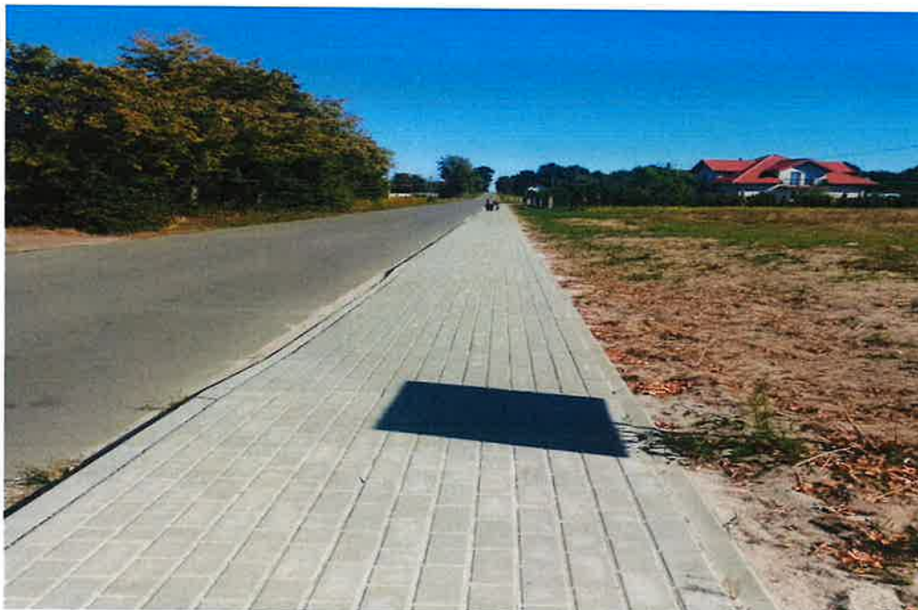
1. Budowa chodnika w Antoninie,
