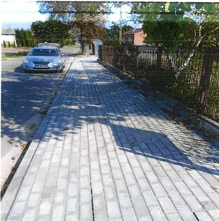
5. Budowa chodnika w miejscowości Wólka Czarnogłowska.
