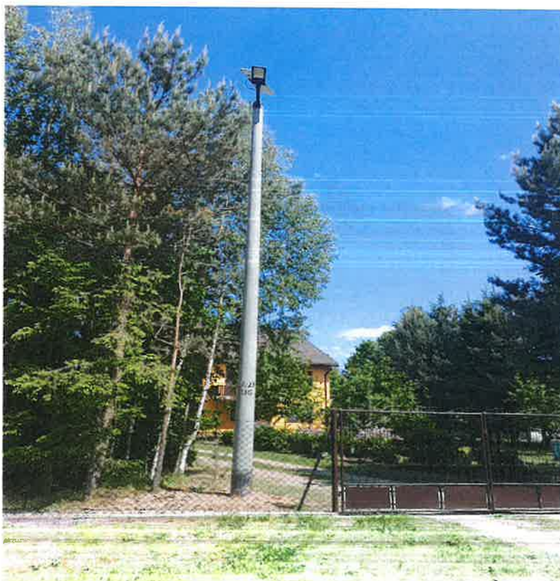
5. Budowa oświetlenia ulicznego w miejscowości Wólka Kobyłańska.
