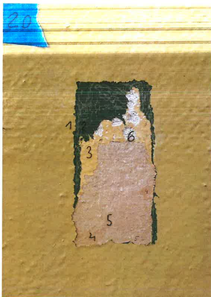
19 nawa główna, ściana bezpośrednio w wejściu, prawa strona
